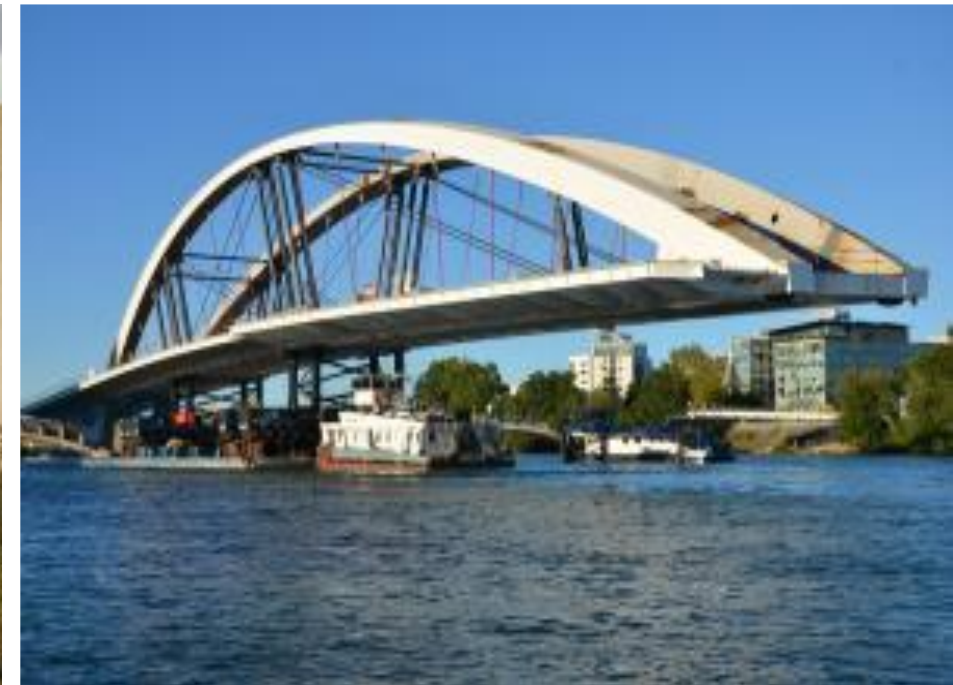
Transport fluvial du pont Raymond-Barre (Lyon)
