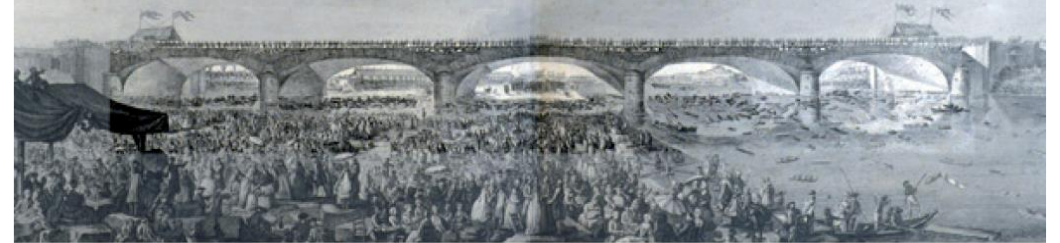
Cintres du pont de Neuilly, même source.
