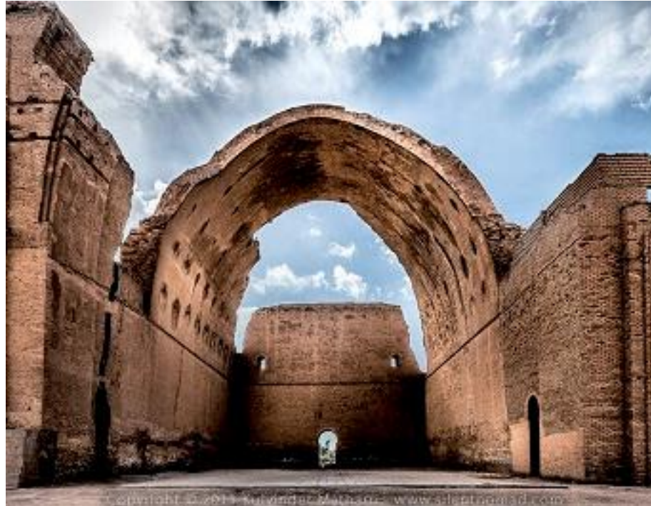
Une voûte en berceau à forme funiculaire au palais de Ctésiphon en Irak
