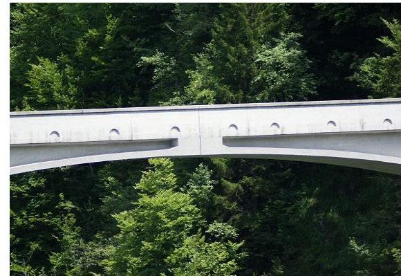
Pont et dispositif constructif de la troisième rotule par Robert Maillard :
