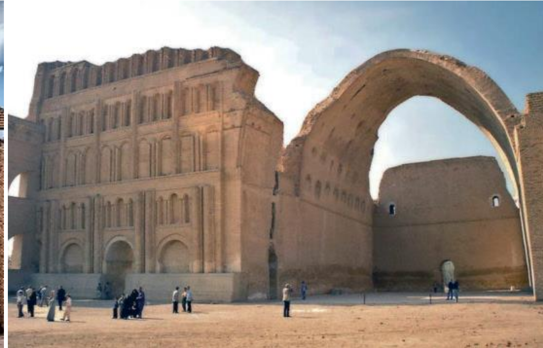
Une voûte en berceau à forme funiculaire au palais de Ctésiphon en Irak
