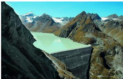
Le barrage de la Grande Dixence, le plus haut d'Europe, est situé dans la vallée de Dix en Suisse. Lac de rétention contient 385 millions de  $m^3$  d'eau. Production : 2000 MW. Sa construction s'étale de 1953 à 1961.
