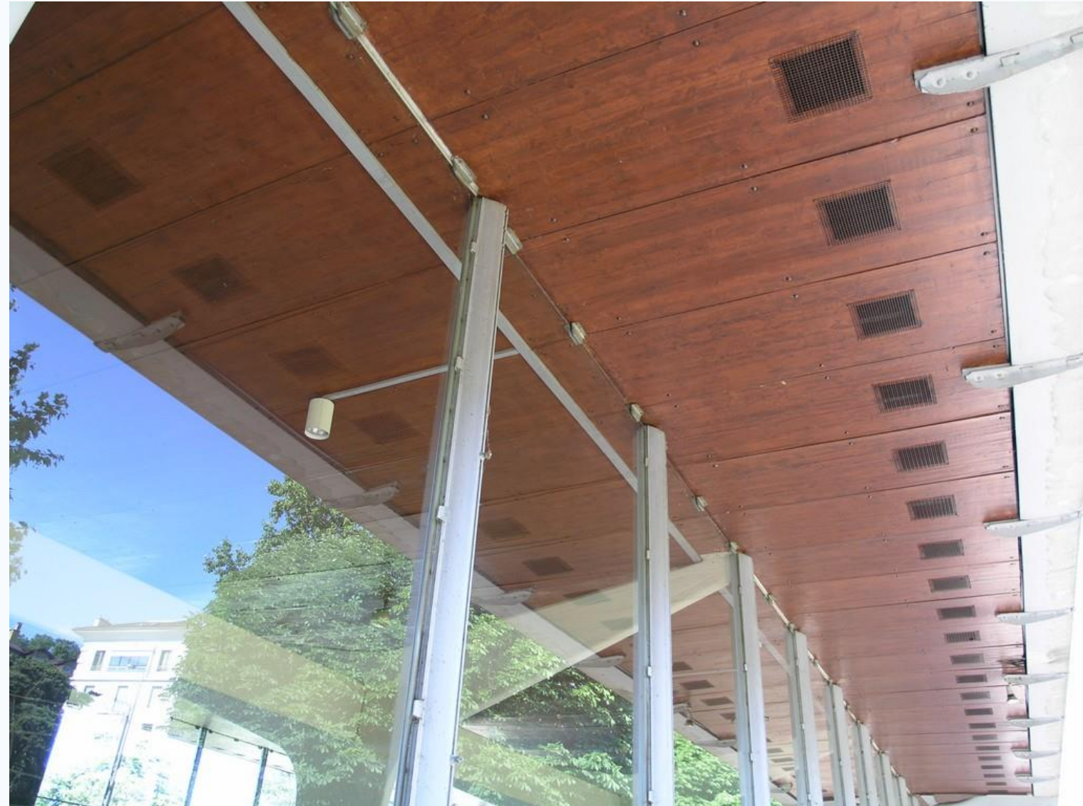
Sous face en bois et potelets de façade formant tirants
